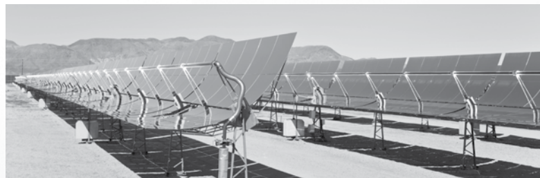
Fig. 3.3.1 Parc solaire d'une centrale à concentrateurs cylindro-paraboliques
