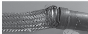
Fig. 4.1.3 Défaillance de la tresse au niveau du raccord
